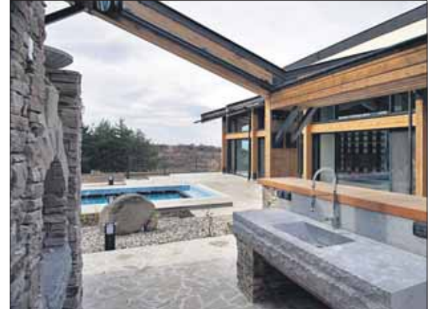
Отопляемата част на жилището е отделена от неотопляемия гараж и сервизните помещения, за да се избегнат редица технологични проблеми и термомостове
