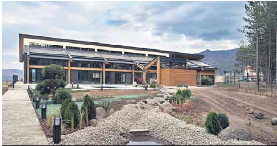
В строителството на къщата са прилагани местни екологични материали като дърво и камък
